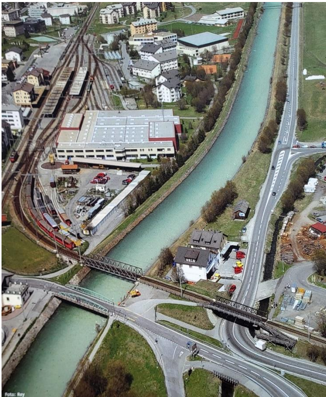
Inn bei Samedan 2003 vor der Renaturierung (blaues Wasser vom Inn, trübes Wasser Flaz)
